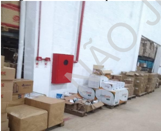
Fotografia 3: Extintor bloqueado
