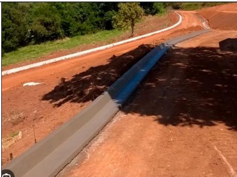
Figura 02. Meio-fio conjugado com sarjeta (TIPO 02).
